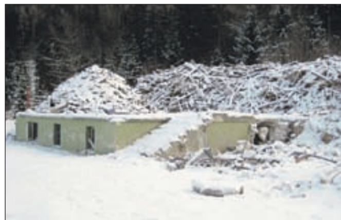
Med prazniki so porušili stari hotel Erika ob cesti na Vršič. Novega, ki bo na tem mestu po načrtih investitorjev zrasel do konca prihodnjega leta, naj bi začeli graditi spomladi.
