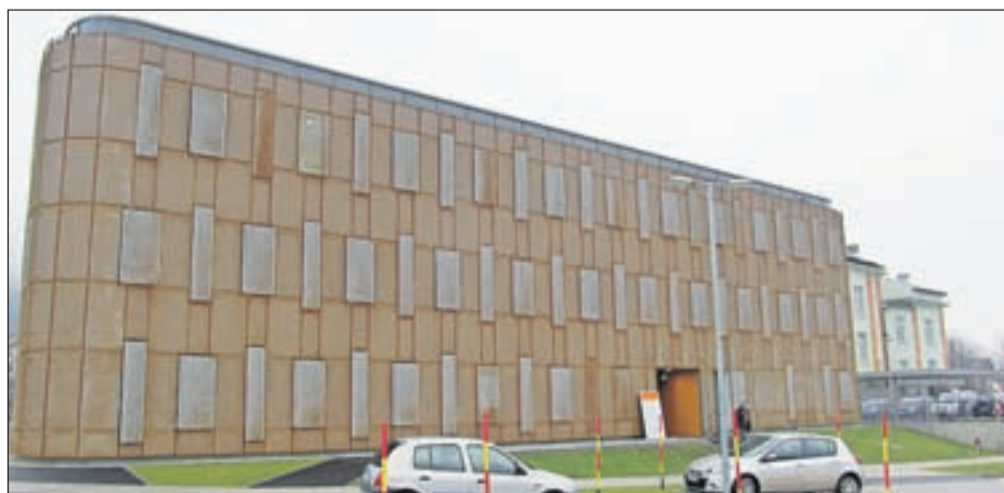
Upravni center Jesenice - fasada je "rjasta", izdelana iz kortenskih plošč.
