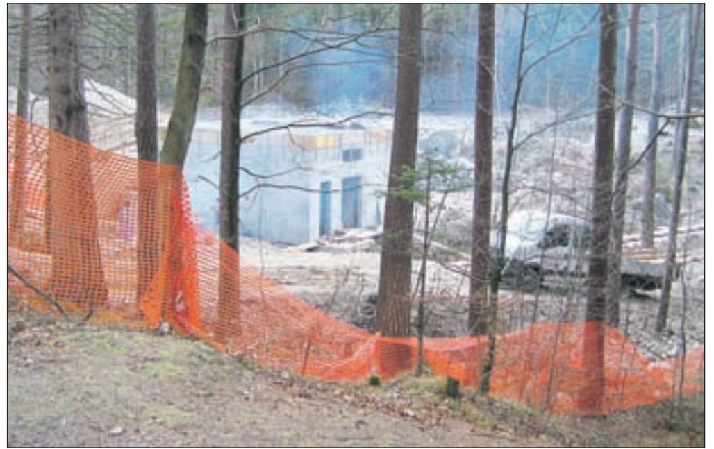
V dolini Završnice že nekaj mesecev poteka gradnja nove male vodne elektrarne Bukovlje.
