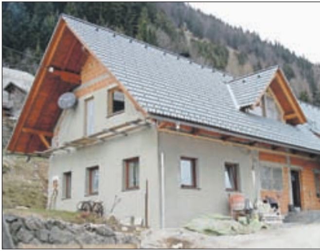
Na pogorišču je v manj kot pol leta "zrasla" nova stavba - hiša in gospodarsko poslopje.
