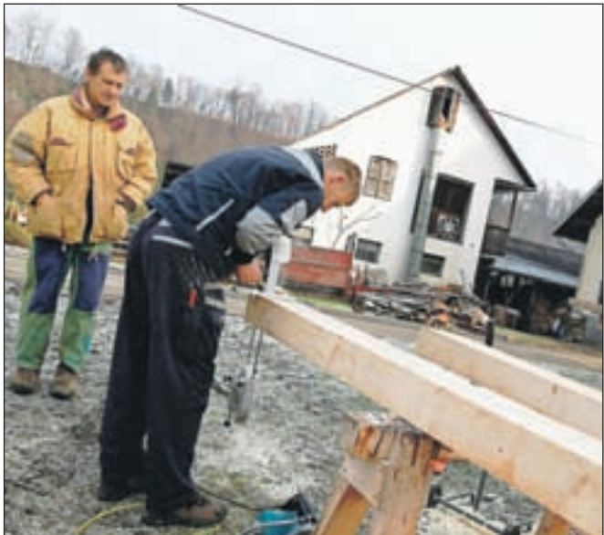
V sredo so že pripravljali les za ostrešje, v enem tednu bo stavba spet pod streho. / Foto: Gorazd Kavčič
