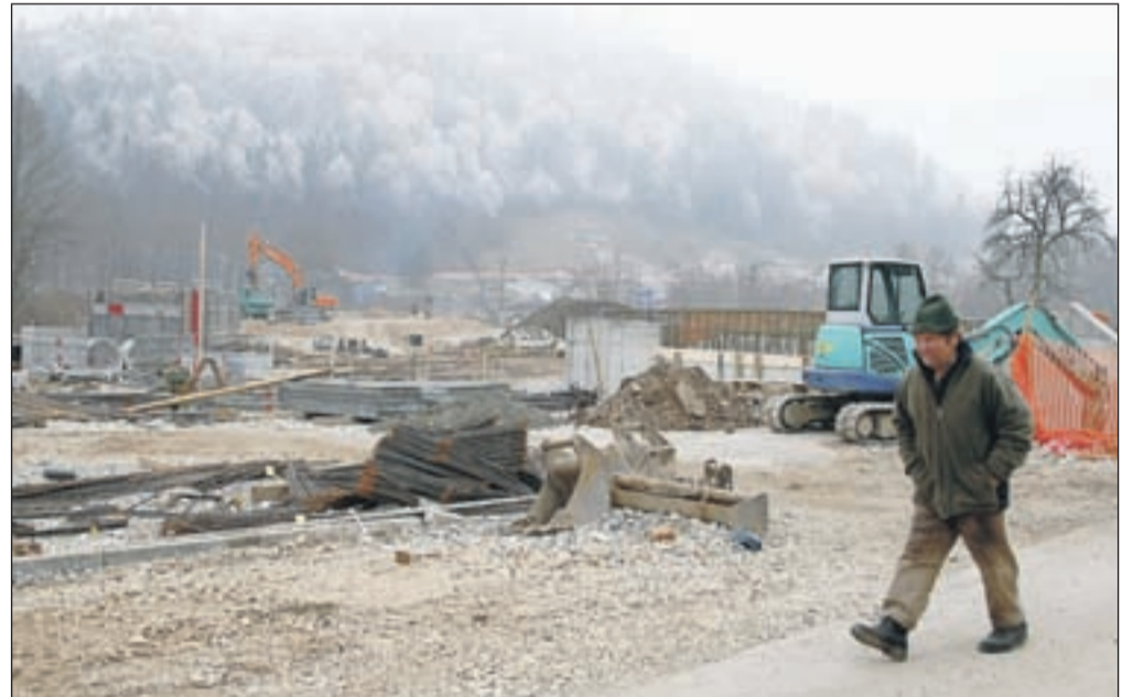
Gradbena dela za poljansko obvoznico na Suhi potekajo, ne pa tudi v predoru, ker je izvajalec gradbeno podjetje Primorje v finančnih težavah. / Foto: Gorazd Kavčič
