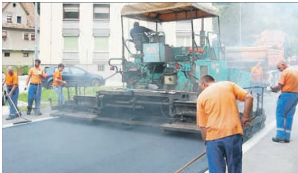
Hkrati z gradnjo nove vodovodne in kanalizacijske infrastrukture so po občini Tržič obnovili tudi številne ceste (na sliki preplastitev cestišča v Ravnah). / Foto: Občina Tržič
