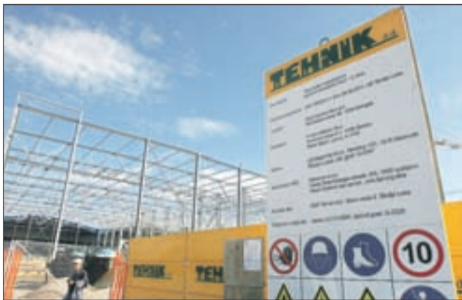
Po dokončani drugi fazi gradnje tovarne Filc v Škofji Loki se je selila tudi uprava in proizvodne linije. / Foto: Tina Dokl
