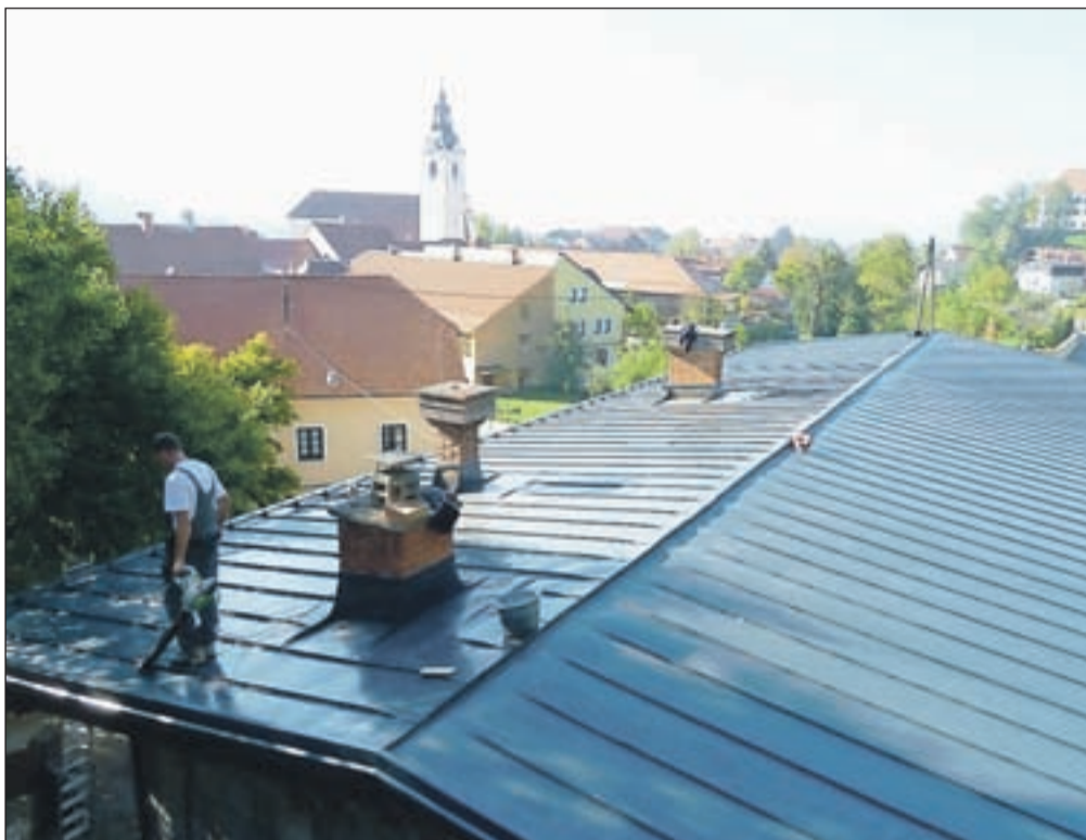
Nova streha t. i. Plečnikove železniške postaje v središču mesta
