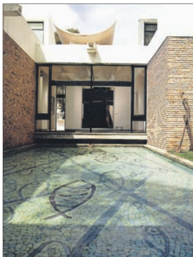
Cilindrični jadra na strehi se odlično stapljata z naravnim okoljem, hkrati pa sta namenjeni tudi zbiranju deževnice, potrebne za delovanje vodometov. V ospredju pod vodo mozaik Georga Braqua.
