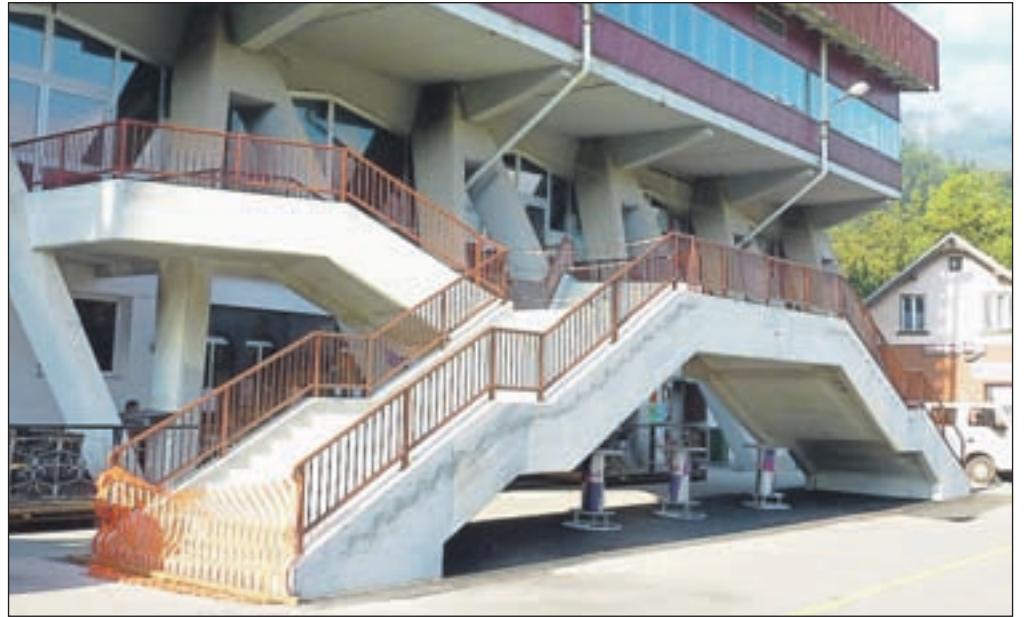
Novo zunanje stopnišče ob hali Podmežakla je zgrajeno in čaka na tehnični pregled.
