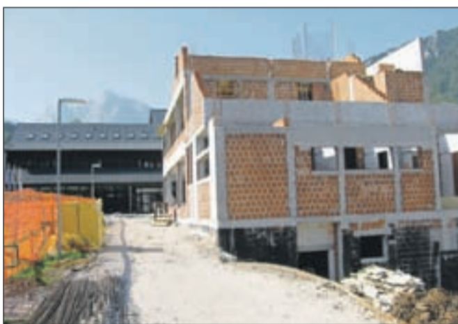
Občina Kranjska Gora bo obnovo osnovne šole zaključila junija prihodnje leto, do septembra pa bo dokončala novo kuhinjo, učilnice nad njo in sanitarije. / Foto: Marjana Ahačič
