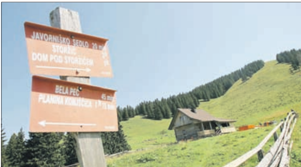
Za osrednji planšarski objekt Agrarne skupnosti Javornik je inšpektorica začetek izvršbe prekinila. / FOTO: TINA DOKL
