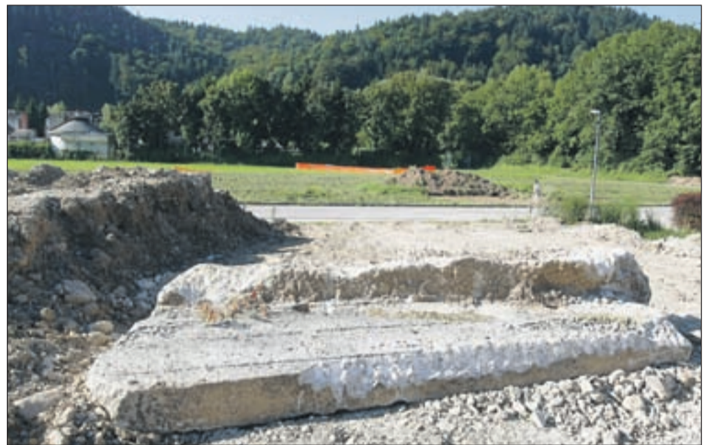
S protestom, med katerim je posredovala celo policija, so v torek člani civilne iniciative ustavili gradbena dela na Suhi, včeraj dopoldne na travniku ni bilo gradbenih strojev, trava pa je bila pokošena. / Foto: Gorazd Kavčič
