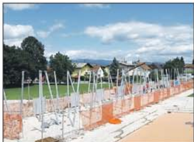
Češminov park bo kmalu bogatejši za paviljon, pod katerim bodo lahko pripravili še več prireditev. / Foto: Občina Domžale
