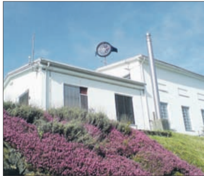
V Medvodah so postavili prvo pilotno vetrno elektrarno v Savskih elektrarnah Ljubljana.
