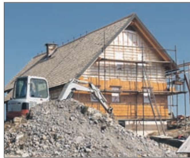
Krekova koč na Ratitovcu med obnovo
