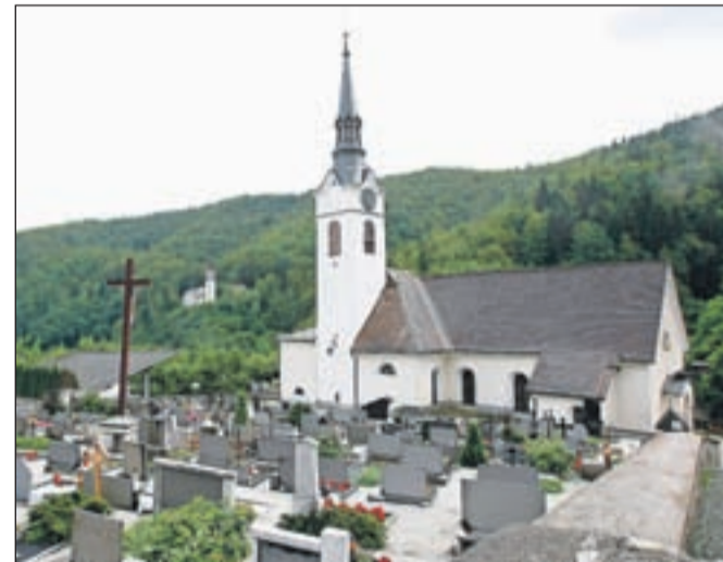
Cerkev sv. Lenarta je zdaj obnovljena, na občini Radovljica pa se ta čas ukvarjajo z načrtovanjem sanacije plazu pod cerkvijo. / Foto: Gorazd Kavčič
