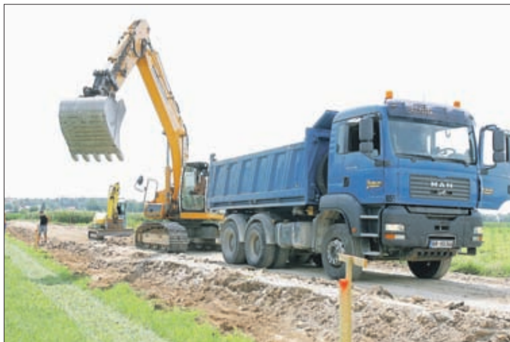
Delavci Gorenjske gradbene družbe morajo rekonstrukcijo ceste Hotemaže-Olševke končati do konca avgusta. / Foto: Tina Dokl
