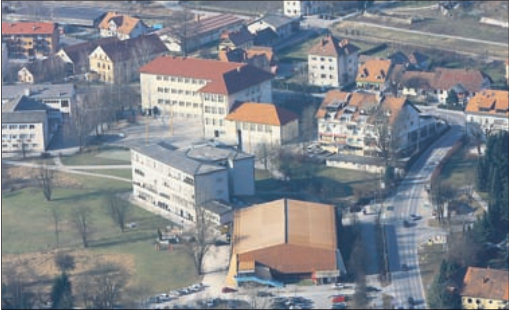
Obe kamniški osnovni šoli sta nujno potrebni obnove, saj sta bili zgrajeni med 2. svetovno vojno oz. takoj po njej, a, kot kaže, se bo letos začela le obnova OŠ Toma Brejca.
