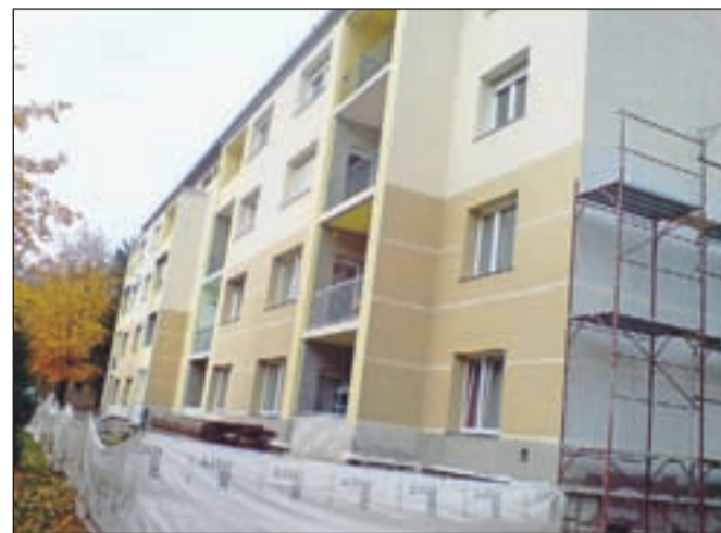
Investicijo v prenovu fasade bodo stanovalci bloka na Titovi cesti na Jesenicah plačevali še prihodnjih šest let. Stroški ogrevanja so že sedaj nižji za 20 do 30 evrov.
