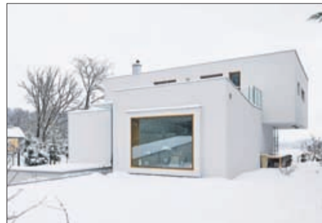
Vila na Bledu iz leta 2009. Moderno zasnovana vila, ki se odpira s pogledi na Blejsko jezero. Arhitekt Robert Potokar s Špelo Kuhar in Blažem Budjo. / FOTO: MIRAN KAMBIČ
