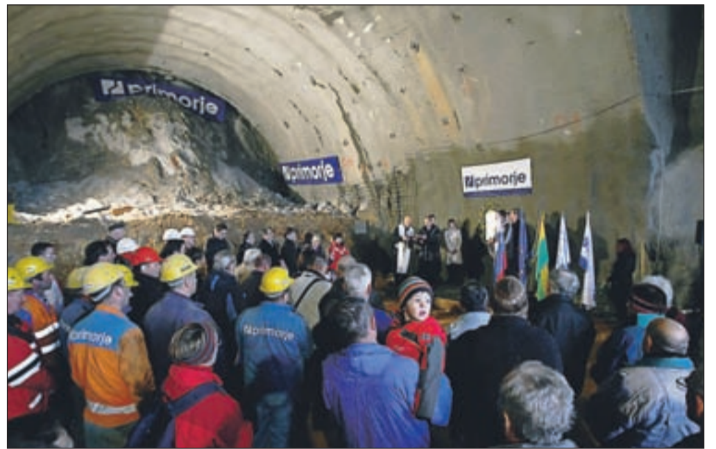
Z blagoslovom kipca sv. Barbare ob južnem vходу so se začela gradbena dela v predoru pod Stenom na trasi poljanske obvoznice. / Foto: Gorazd Kavčič
