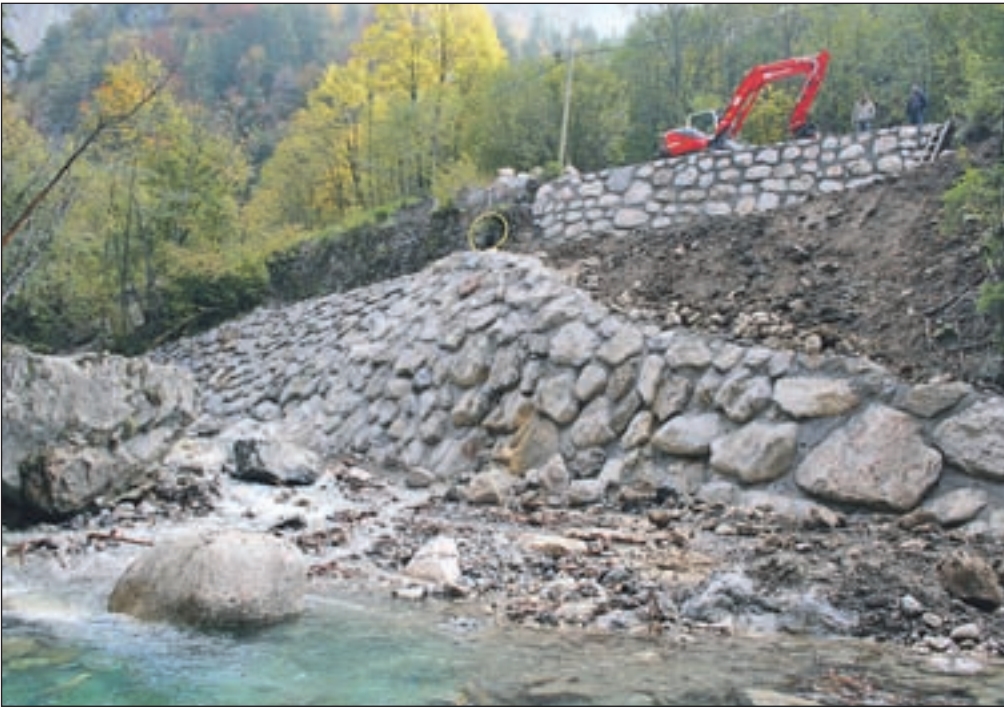
Strmo brežino Tržiške Bistrice nad cesto v Dolino varuje nov oporni zid.
