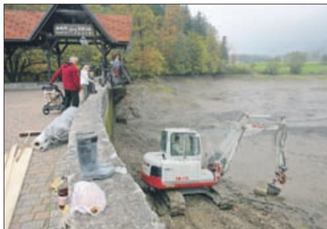
Ta teden se je začela sanacija jezera Črnava. / Foto: Tina Dokl
