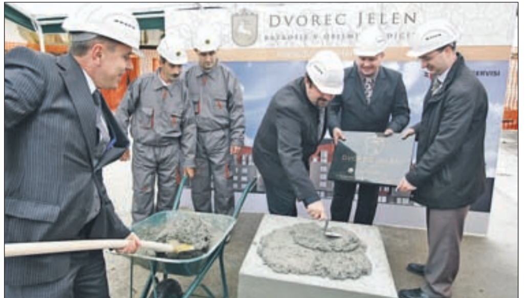
Direktor Elektroservisov Ivan Hozjan je v družbi direktorja Nepremičnin v podjetju Elektroservisi Vojka Vrtačiča ter kranjskega župana Damijana Perneta in podžupana Staneta Štravsasa zasadil lopato in poskrbel za temeljni kamen Dvorca Jelen. / Foto: Gorazd Kavčič
