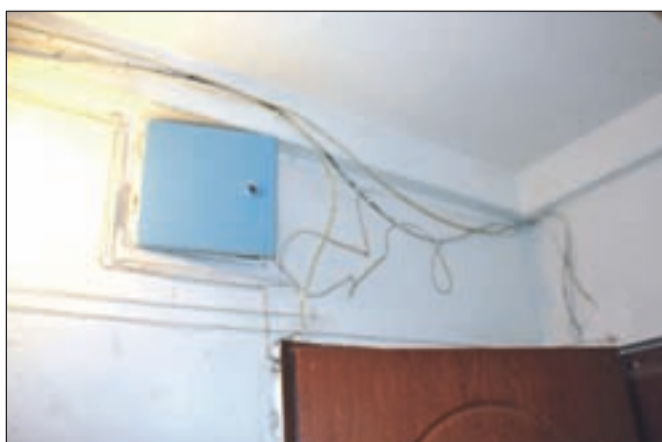
"Inovativna" električna napeljava na hodniku
