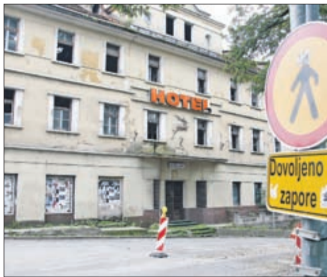
Razpadajoči hotel Jelen in staro Merkurjevo poslovno stavbo naj bi porušili še v tem mesecu, na istem prostoru pa bodo postavili dvorec Jelen s stanovanji, poslovnimi prostori in garažami. / Foto: Gorazd Kavčič
