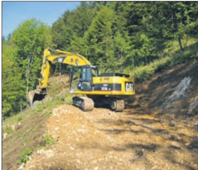
Gradnja gozdne ceste se je že začela.
