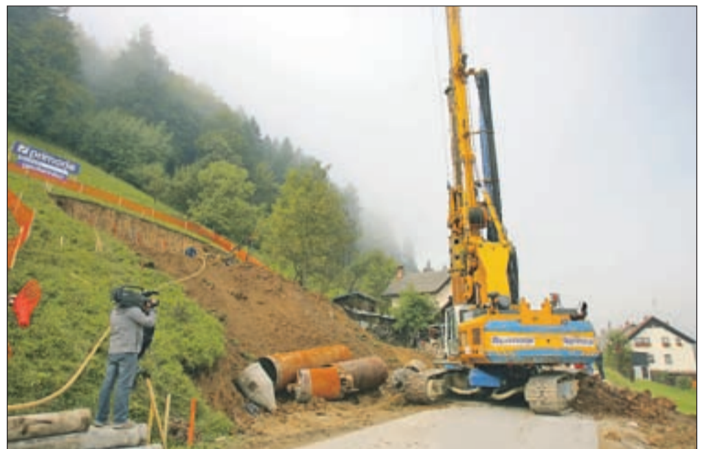
Na vhodu v predor pod Stenom so začeli z vgradnjo posebnih pilotov za zaščito začasnega severnega portala predora. / Foto: Tina Dokl
