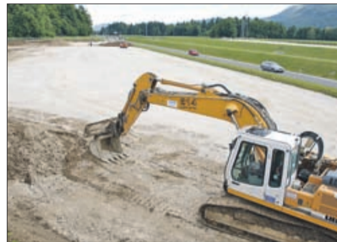
Jeseni bodo na obeh straneh izvoza za Radovljico na gorenjski avtocesti začeli graditi bencinska servisa.
