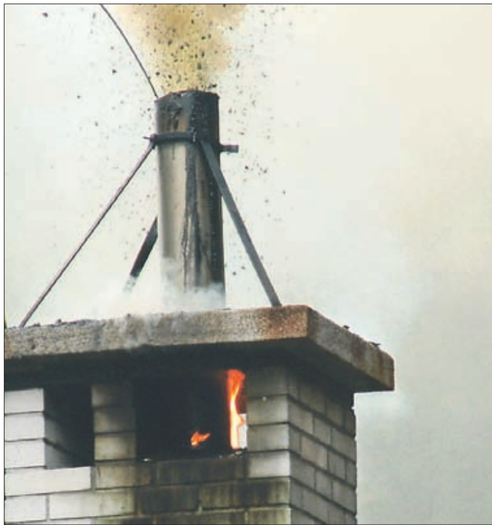
Požar nastane v dimniku, če ta ni redno vzdrževan in pregledan.
