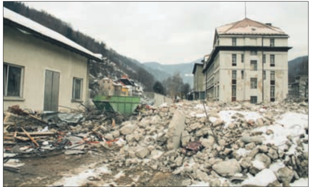
Stare in nove upravne stavbe ter objekta z vratarnico ni več, na rušenje čaka le še nekdanja železniška postaja (na levi).
