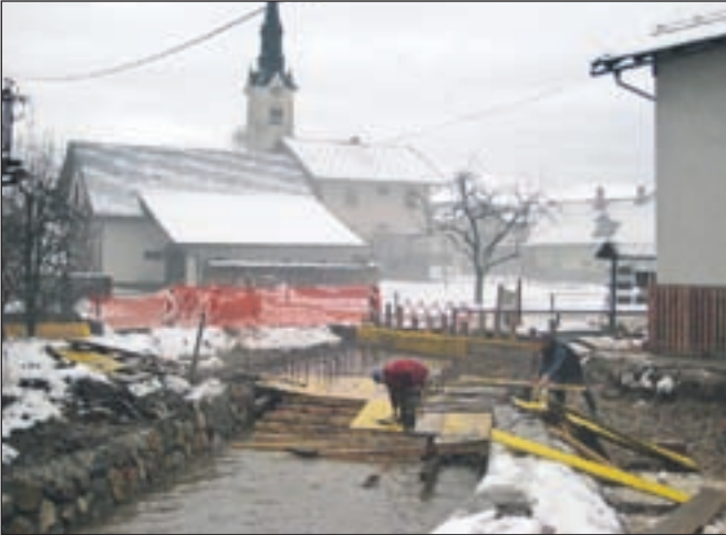
Potok Žabnica je včeraj v Zgornjih Bitnjah podrł opaž za novi most. / Foto: Simon Šubic
