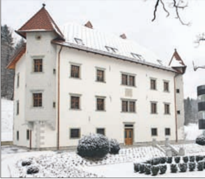
Stari, popolnoma obnovljeni dvorec bo namenjen zahtevnejšim gostom. V velikih sobah jih bodo čakale postelje z baldahinom in velike, udobne kopalnice.
