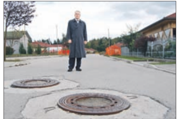
Investitor mora pred gradnjo novih objektov urediti okrog štiristo metrov ceste, po kateri se vozijo stanovalci stanovanj v naselju Zbiljski gaj, tudi Sandi Kodrič (na sliki).
