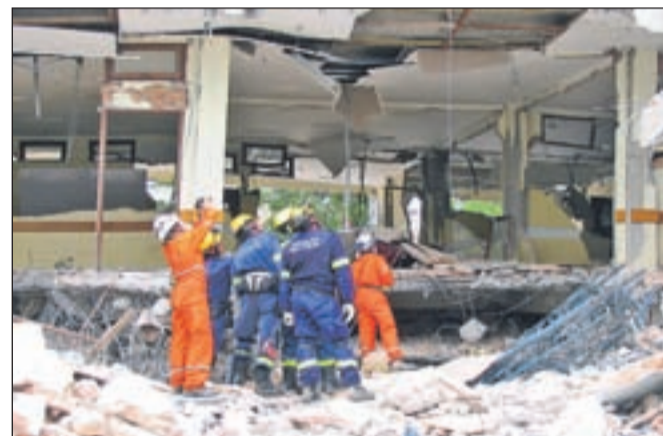
Slovenski reševalci in avstralski gasilci ugotavljajo stanje na ruševinah izobraževalnega centra.
