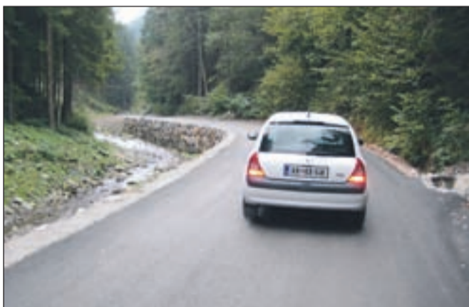
Obnova ceste in brežin je stala pol milijona evrov.
