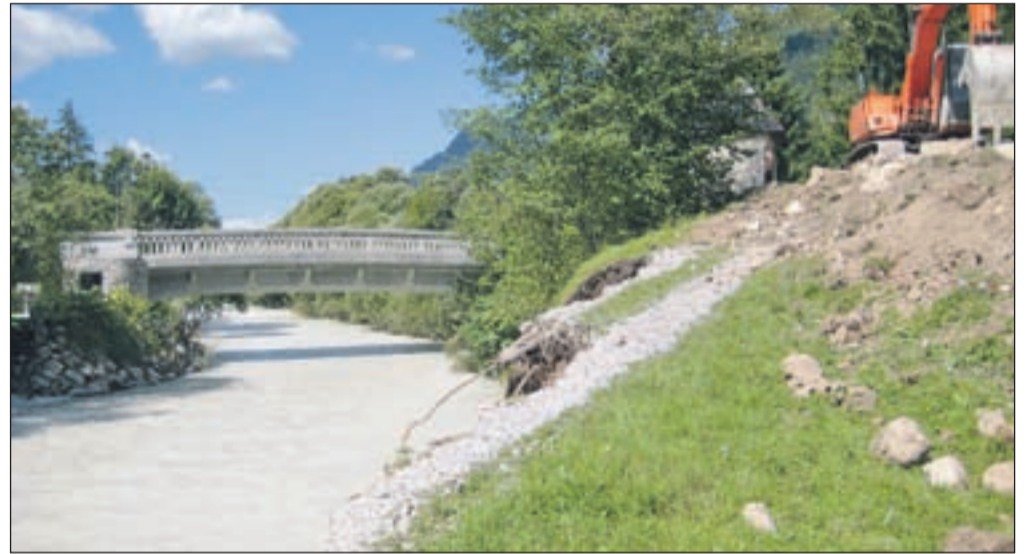
Narasla voda je dobesedno odrezala dovodno pot do počitniškega objekta v Mojstrani, zaradi spodjedanja brežine pa je že resno ogrozila tudi bližnji most. / Foto: Marjana Ahačič
