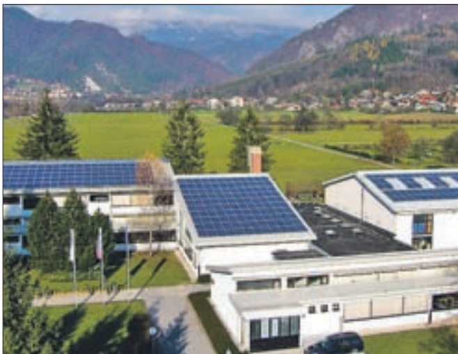
Sončna elektrarna moči 80 kW na OŠ Križe
