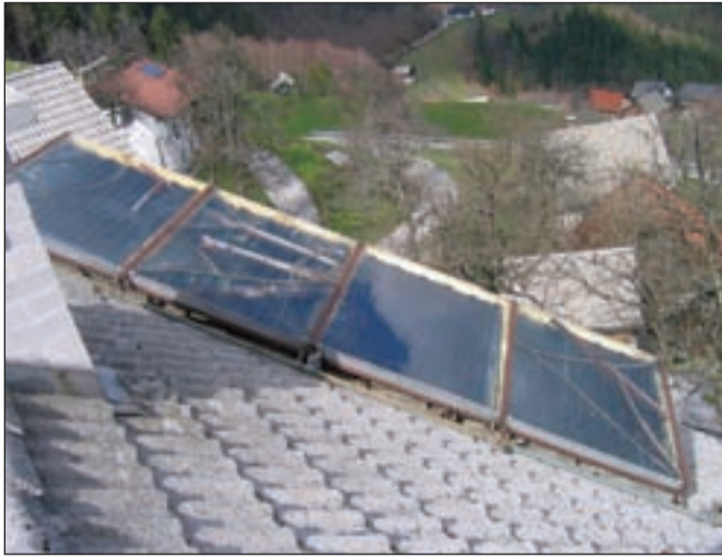
Kolektorje za ogrevanje sanitarne vode so na Škofjeloškem lastniki že izdelovali sami, s projektom Ujemimo sonce pa jih bodo lahko obnovili ali zamenjali z modernejšimi.
