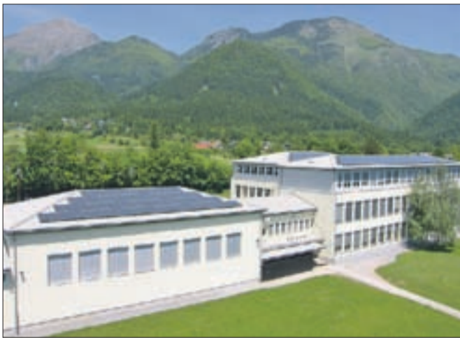
Sončna elektrarna na OŠ Matije Valjavca v Predvoru moči 60 kW
