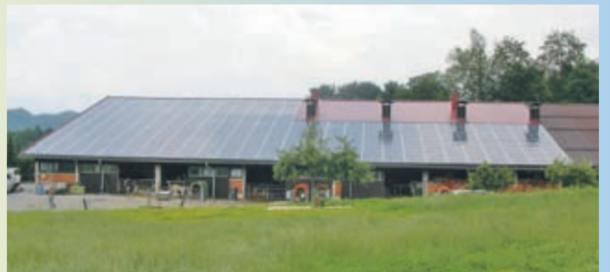
Samostojni podjetnik Bruno Blatnik je letos zgradil največjo sončno elektrarno na Gorenjskem. V Zavrhu pod Šmarno goro je na strehi starega hleva zrasla integrirana sončna elektrarna s 102 kilovata nazivne moči.
