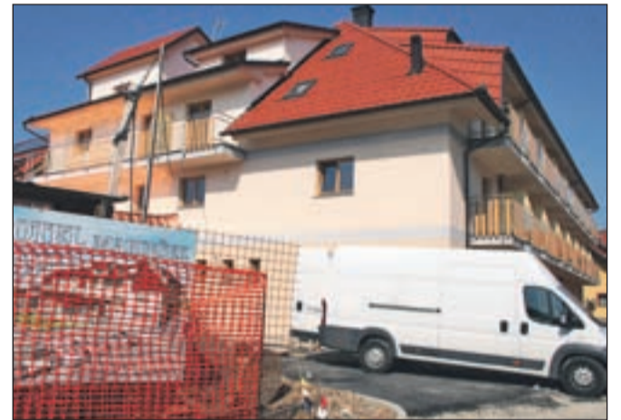
Ob hotelu so že nova parkirišča, kmalu pa bodo uredili tudi okolico.
