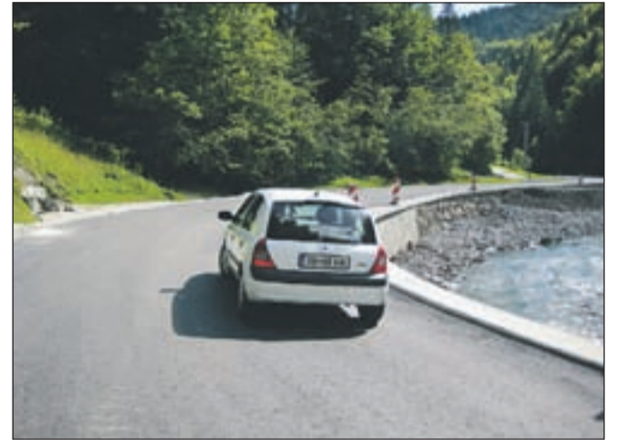
Prvi odsek davške ceste je obnovljen, rekonstrukcija celotne davške ceste pa bo predvidoma končana leta 2012.
