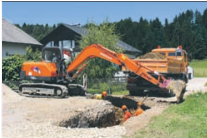
Skupaj z gradnjo kanalizacije po občini menjavajo tudi vodovodne cevi.
