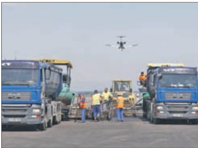
SCT je dela prve faze obnove vzletno-pristajalne steze opravil pod prometom in pred rokom. / Foto: Gorazd Kavčič
