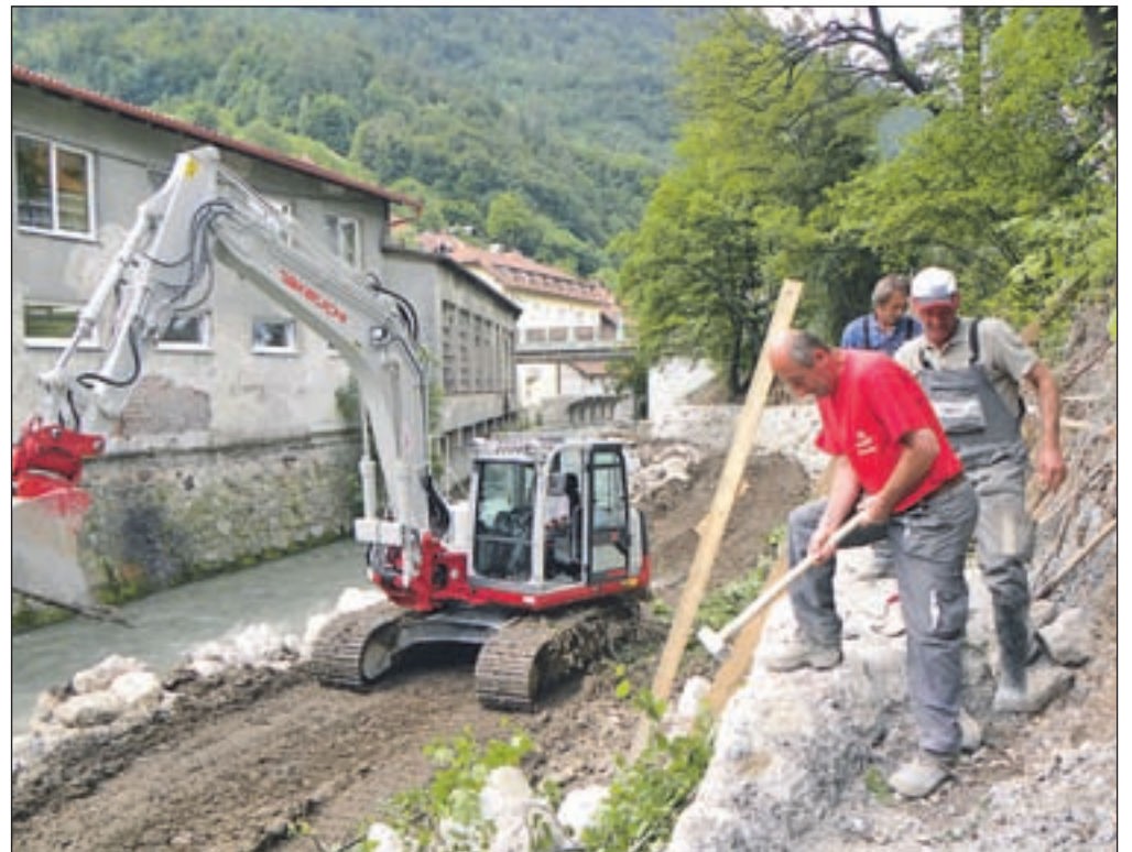
Brežino pod tržiško šolo bodo utrdili z novim opornim zidom.
