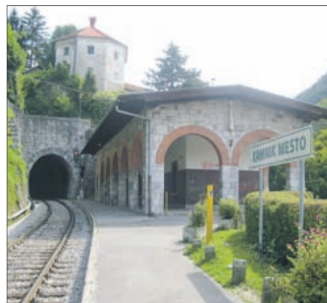
Plečnikova železniška postaja je potrebna prenove.
