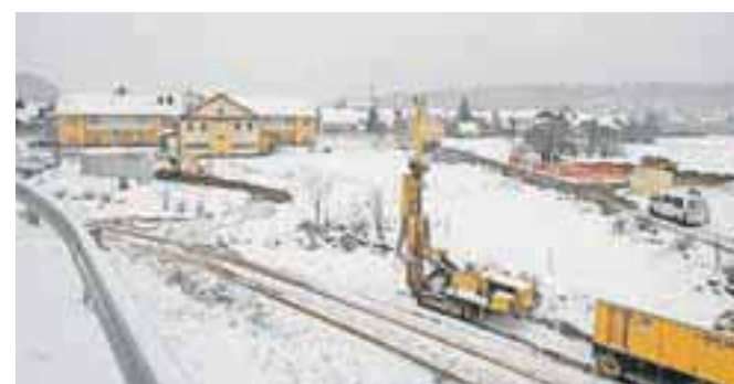
Graditi so začeli že pred zadnjim sneženjem. / FOTO: TINA DOKL
