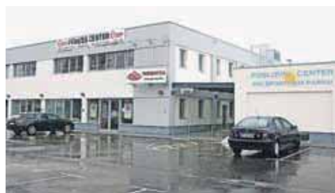
Med pogodbami, ki jih pregleduje protikorupcijska komisija, je tudi pogodba za gradnjo poslovnega objekta pri športnem parku v Radovljici.
