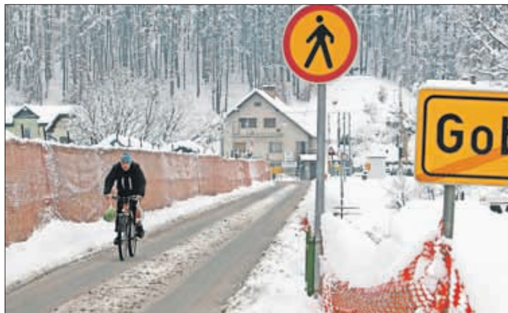
Most v Podnartu obnavljajo. / FOTO: GORAZD KAVČIČ
