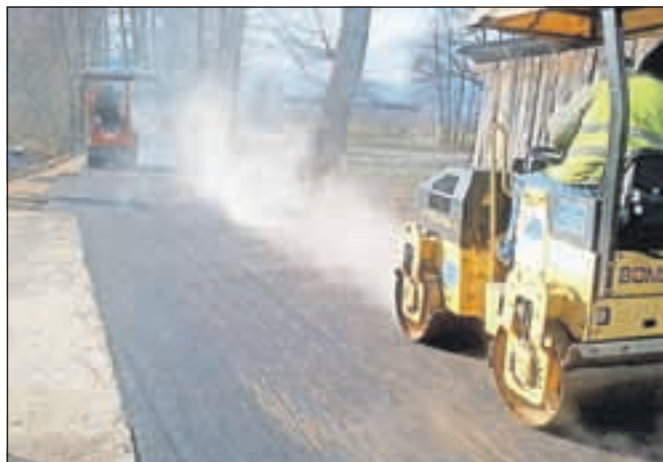
Preplastitev odseka ceste v Studenčah
