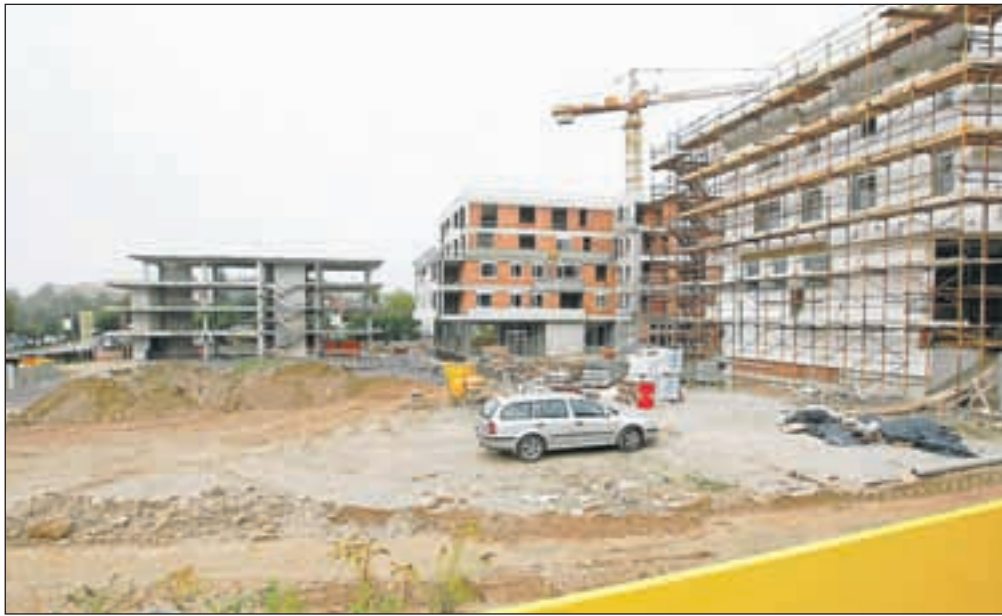
Gradnja nove knjižnice teče počasneje kot gradnja treh stanovanjsko-poslovnih objektov za njo. / FOTO: GORAZD KAVČIČ
