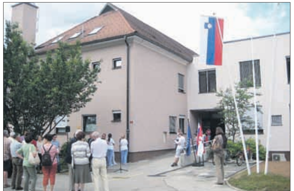
V Radovljici so zaključili energetske sanacije leta 1974 zgrajenega zdravstvenega doma.
