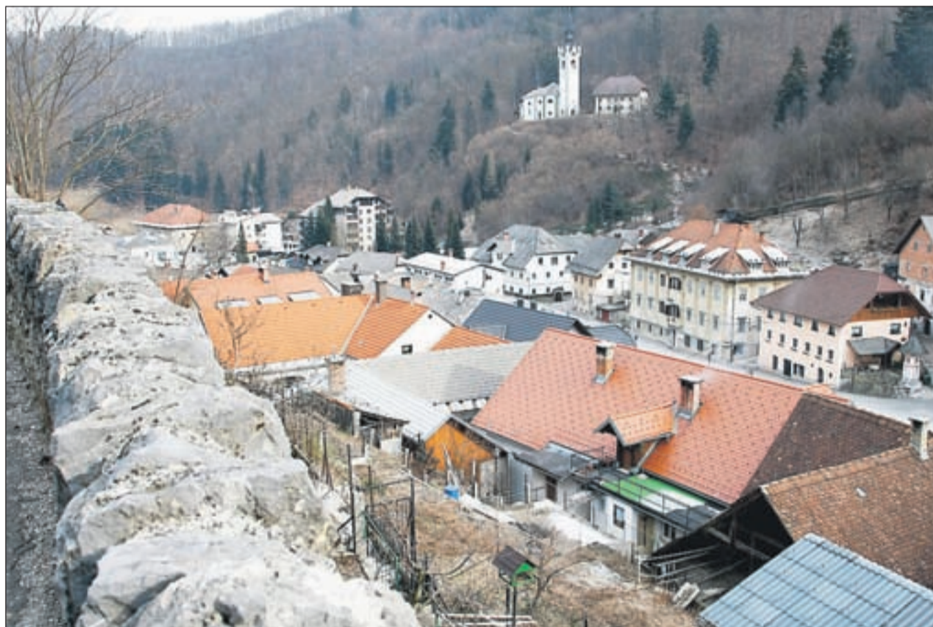
Sanacija škode, ki je nastala po poplavih, je v Kropi v glavnem zaključena. Za gradnjo novega vodovoda in komunalne infrastrukture pa bi občina potrebovala še vsaj 8 milijonov evrov. / FOTO: GORAZD KAVČIČ
