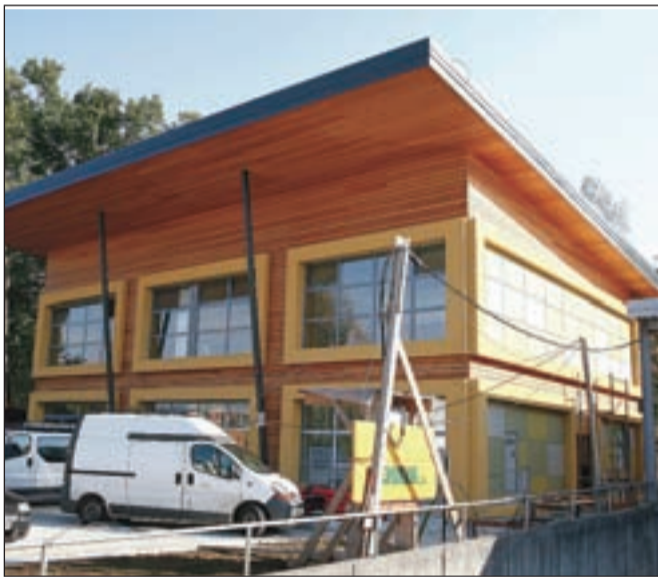
Čebelarski center v Lescah bo zgrajen do konca prihodnjega meseca, odprt pa do konca leta. | FOTO: GORAZD KAVČIČ
