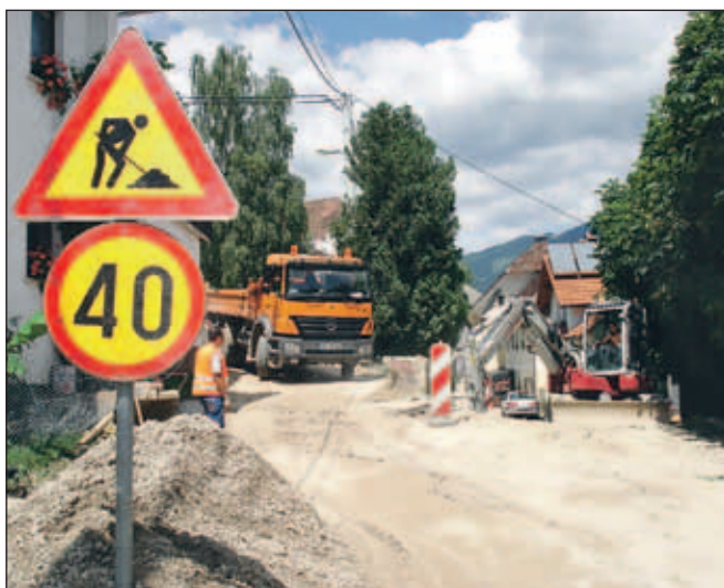
V Ljubnem obnavljajo vodovod, cesto in komunalne vode.
