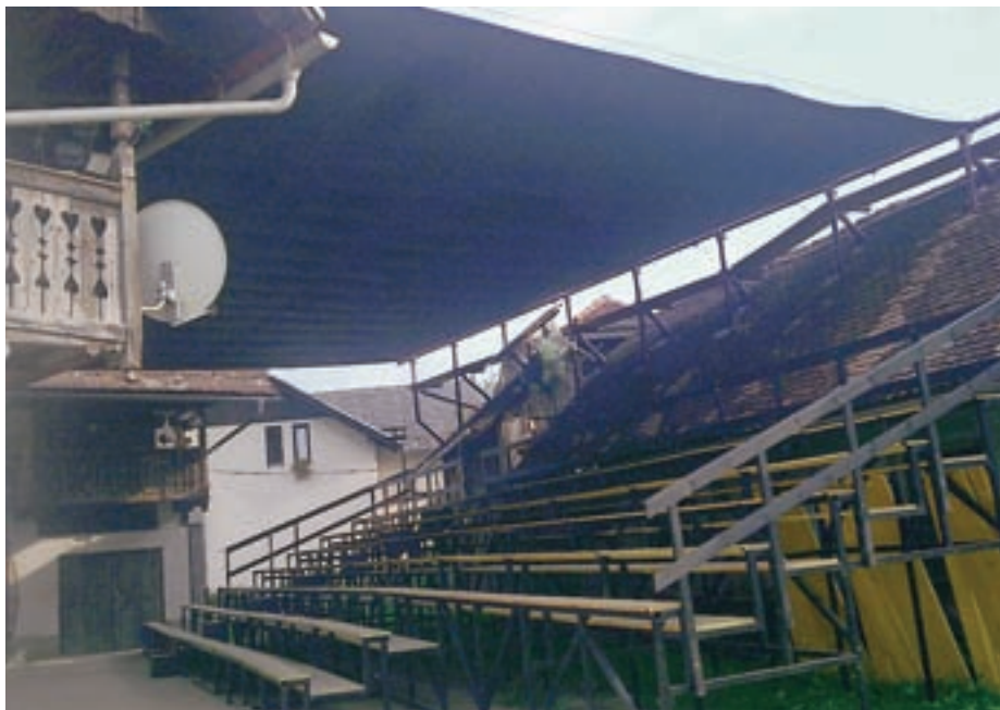
Ker so predstave na prostem preveč odvisne od vremena, so v letnem gledališču zgradili premično streho.
